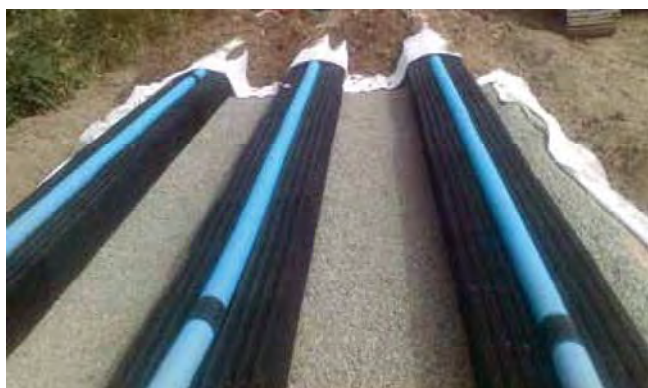
Infiltra-anlegg for en bolig.
