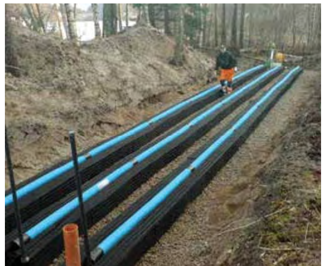
Infiltrasjonsgrøft med BioModuler.
