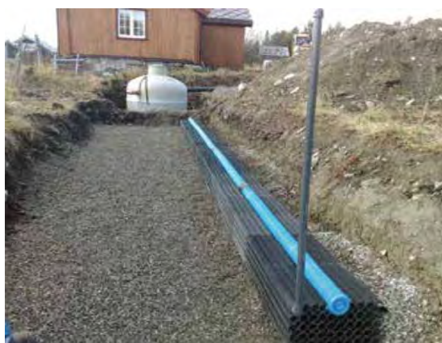
Infiltra-anlegg for en bolig.
